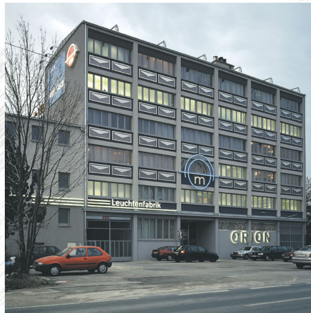
ORION - Leuchtenfabrik 1230 Wien, Oberlaaer Straße 284 Tel.: +43/1/616 67 54 oder 616 68 29 Fax: +43/1/615 64 65
